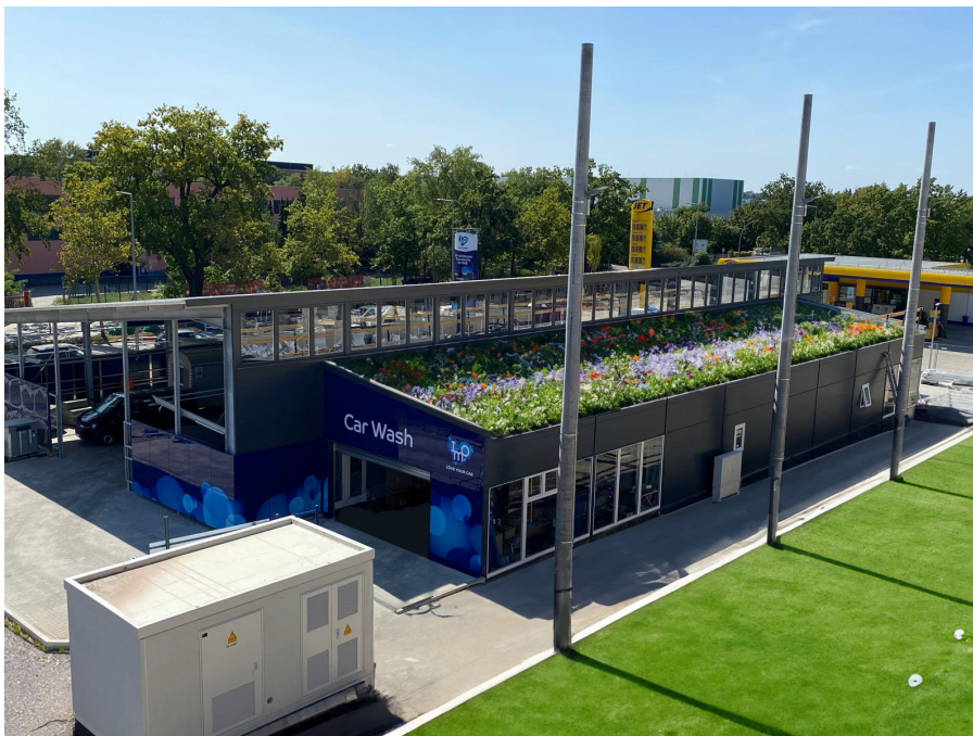
Außenansicht der neuen IMO Anlage in Berlin-Marienfelde. Copyright: IMO Autopflege GmbH
